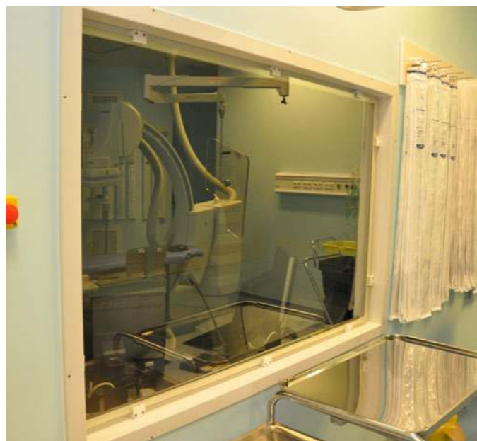
Vitraj cu protecție la radiații, Laborator radiologie
