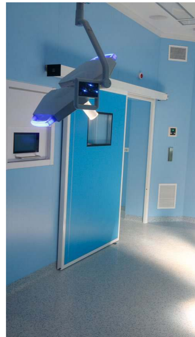
Ușă etanș ermetică, Bloc operator
