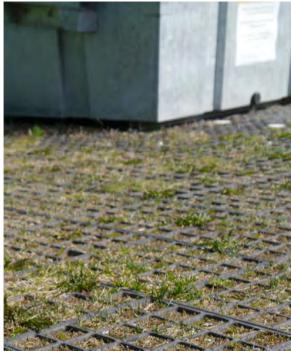
De peste 20 de ani, Purus Plastics a fabricat sistemul de consolidare a solului permeabil ECORASTER®, fabricat din 100% materiale reciclate (LDPE). Prima noastră instalare a ECORASTER E50 „Classic” cu peste 20 de ani în urmă, a fost la centrul de colectare a deșeurilor. Această instalare specifică se efectuează în climat rece și grilajul a fost supus ciclului permanent de îngheț - dezgheț, la fel ca și utilajele de deszăpezire constantă.
