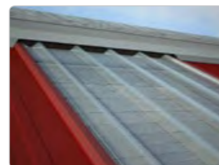
DETALIU CREAMĂ ACOPERIȘ Detaliu special creastă cu garnitură PE-LD
